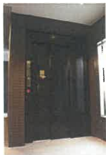
エレベーター
